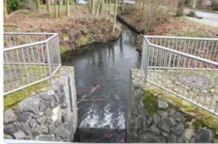
Die Becken am Hammer Bach verfügen zum Teil über elektronisch gesteuerte Stauanlagen (Wehre), die abhängig vom Wasserstand im Becken den Ablauf des Wassers regeln. Steigt der Wasserspiegel über eine voreingestellte Marke an, wird der Verband per SMS benachrichtigt, damit im Falle von Störungen die Störung beseitigt oder im Falle eines Hochwassers die Steuerung notfalls auch manuell betrieben werden kann.
