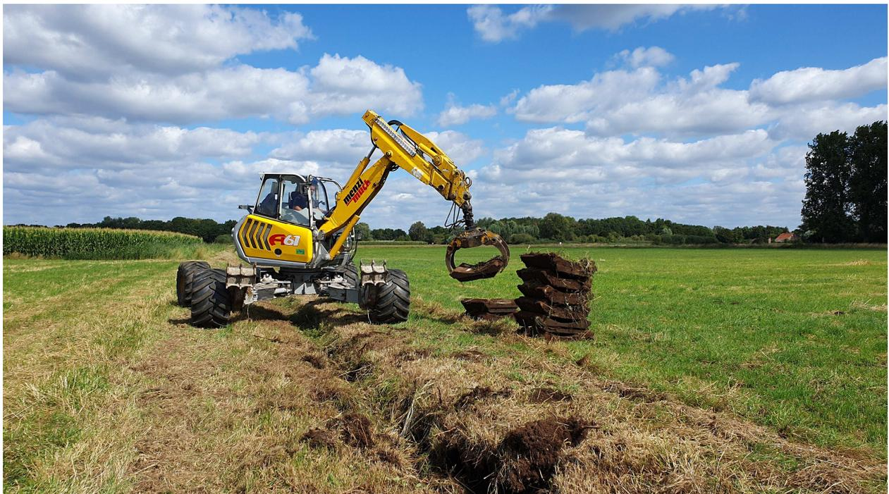
Abbildung 2: Schreitbagger bei der Entnahme von Sohlschalen
